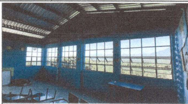
Fotografía 1. Sustitución de ventanas de madera por metal mas vidrio en Modulo 5
