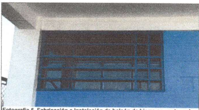
Fotografía 5. Fabricación e Instalación de balcón de hierro en ventana de modulo de baños
