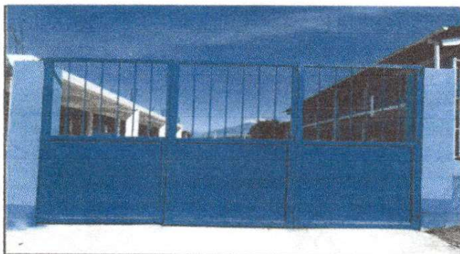
Fotografía 3. Mantenimiento de portón de metal en la entrada principal.
