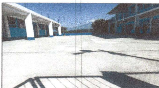
Fotografía 4. Reparación de plancha de concreto de patio.
