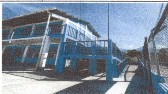
Fotografía 2. Mantenimiento de barandas de metal en todo el establecimiento
